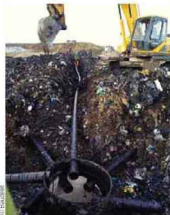
Construction des canalisations de collecte du biogaz dans les massifs de déchets.
