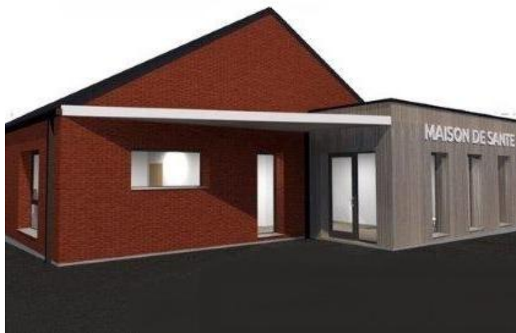
Hélène Liefoghe et son mari ont choisi Pierre Courtois comme maître d'œuvre. Il a notamment travaillé sur la maison de santé de Boeschèpe. (©Bâti Courtois)
