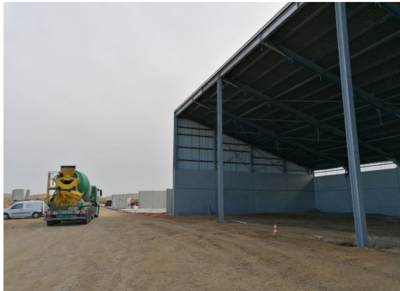
Des panneaux photovoltaïques seront installés sur le hangar.
